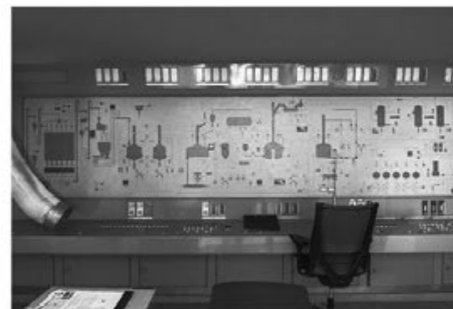
仕込み工程を監視する
